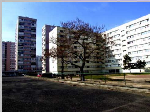
La résidence La Source, construite en 1968, est située dans un quartier concerné par un projet de rénovation urbaine
