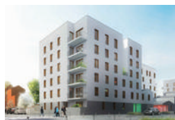
■ LA COURNEUVE , Balzac : 25 logements familiaux. Livraison prévue en juillet 2018.
