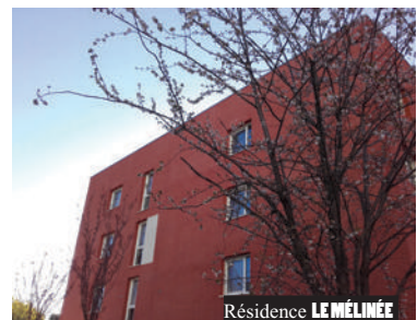
Résidence LE MÉLINÉE à Saint-Denis
