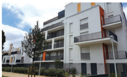
■ LA COURNEUVE , Les Pointes. 58/78 avenue Jean Jaurès : 31 logements familiaux. Livraison prévue en juin 2016.
