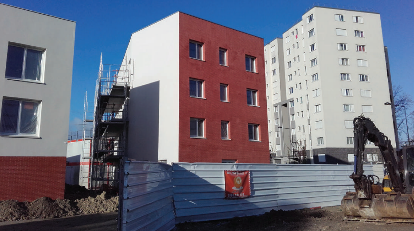
Résidence LE MÉLINÉE à Saint-Denis
