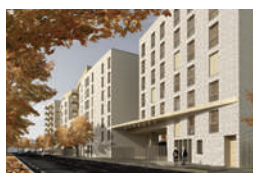
■ SAINT-DENIS , Zac Montjoie : 150 logements étudiants, 61 logements adaptés et 63 logements familiaux. Livrés en janvier 2017.
