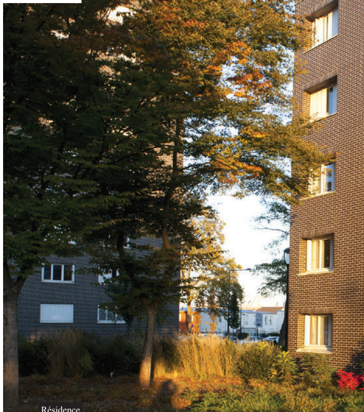
Résidence AUGUSTE DELAUNE à Saint-Denis
