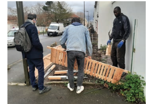
Henri-Barbusse, Villetaneuse : chantier d'insertion professionnelle
