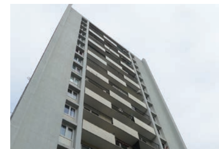
📍 Floréal, Saint-Denis : 649 logements réhabilités en 2020/2021 pour un montant total de 22M€, et des travaux de résidentialisation qui seront réalisés en complément.
